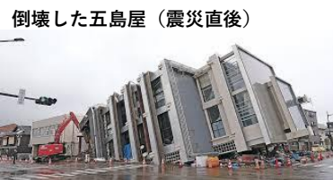
倒壊した五島屋（震災直後）
